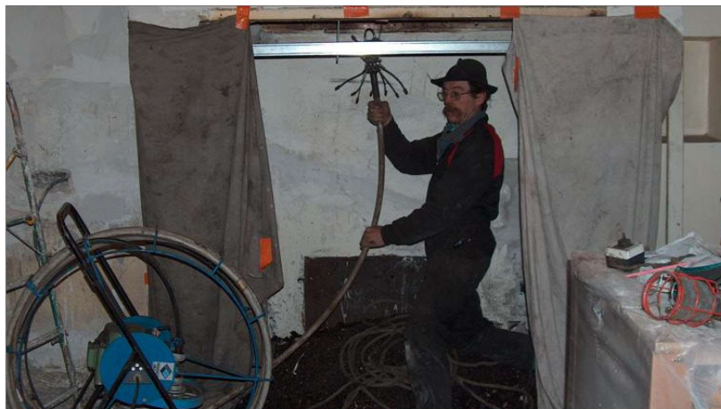
Hervé Gerente-Paquet à l'œuvre sur un toit (à gauche). Hervé Gerente-Paquet ramone les conduits de fumée par le bas, à partir de la cheminée (à droite).
